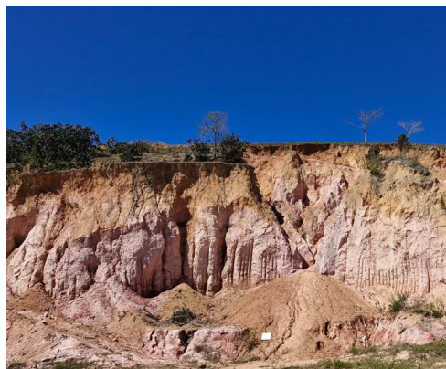
Corte irregular em encosta gerando desmoronamento e erosão
