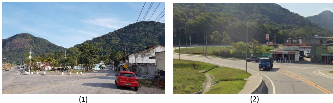
Figura 86 - (1) a (5) Bairro Boqueirão. (6) Expansão urbana no lado oposto da BR-101.
