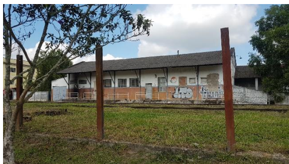
Estação Ferroviária de Capivari.
