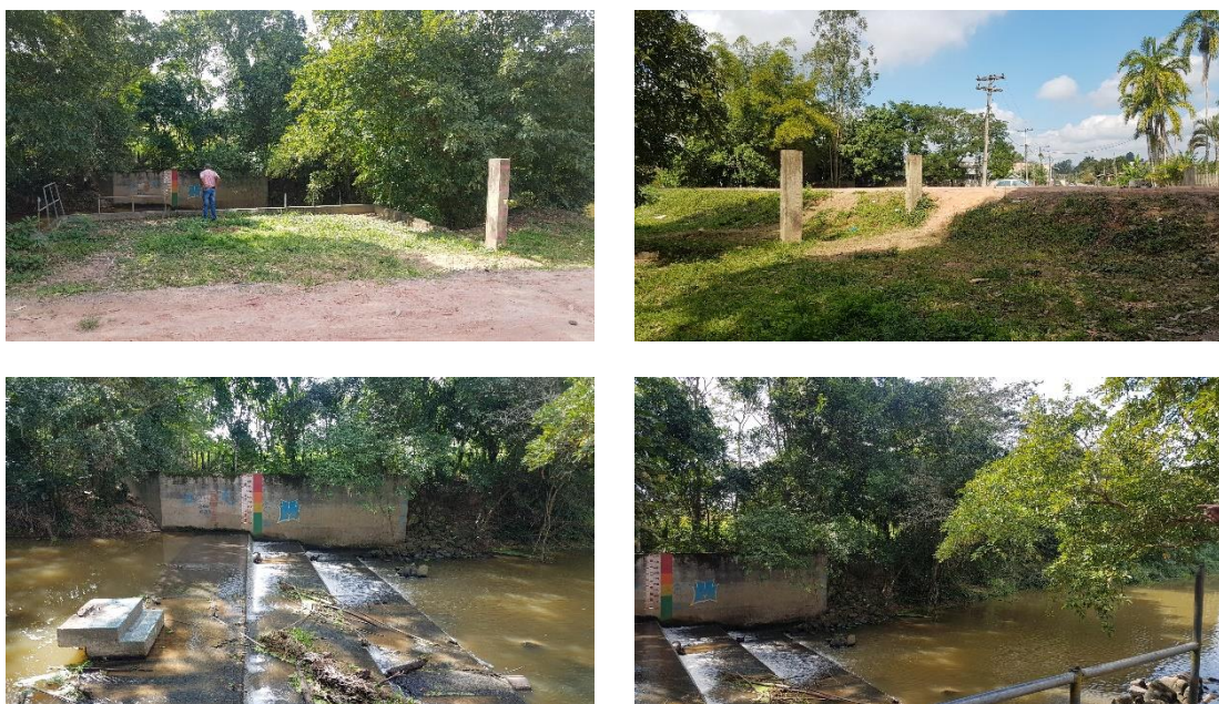
Figura 38 - Registros de parte do Dique do Rio Capivari.
