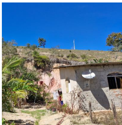
Desmoronamento de encosta devido a corte irregular.
